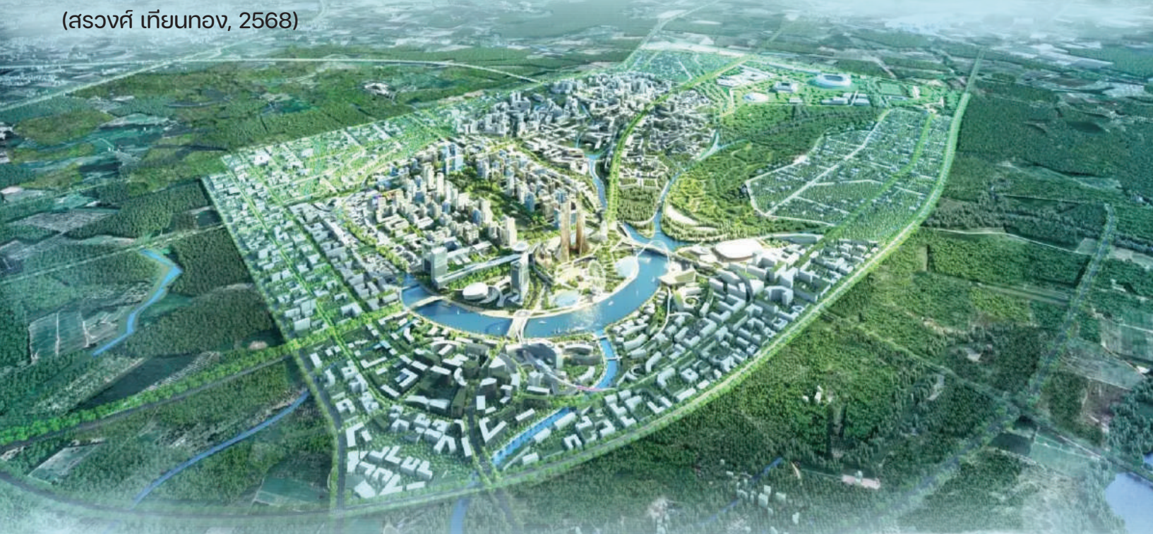
ภาพที่ 12 : โครงการก่อสร้างศูนย์กีฬานานาชาติ (Thailand International Sports Park) ที่มา : กรุงเทพมหานคร (2567)
